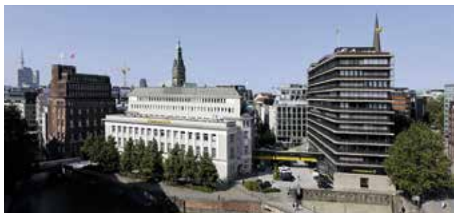
Commerzbank am Neß: Denkmalgeschütztes Hochhaus (1961–1964, Godber Nissen, re.) und zu stark veränderter Altbau
